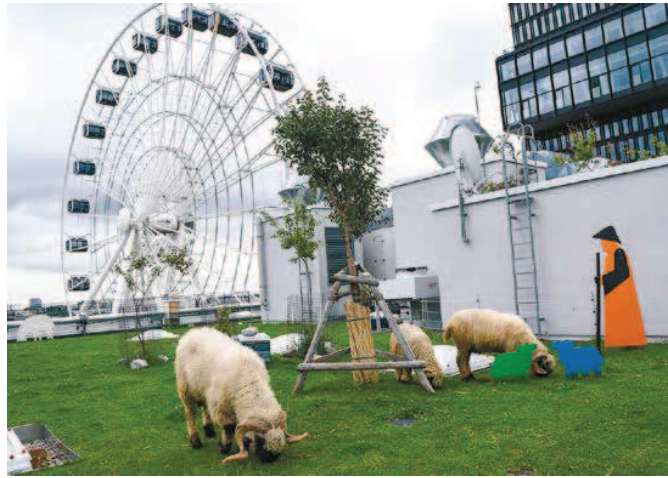
Begrünte Dächer nehmen Regenwasser auf und entlasten so die Kanalisation Foto: Lindenthaler/imagio
